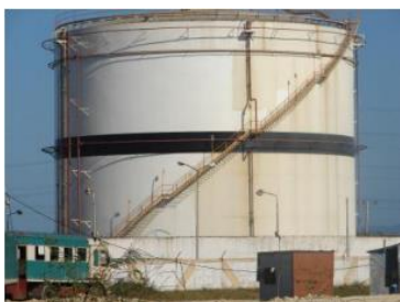
Figura 1. Tanque de almacenamiento de combustible.
