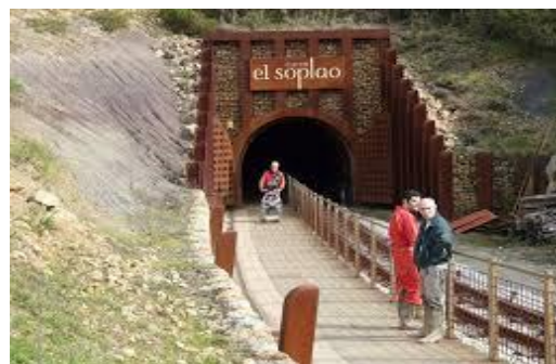
Mina subterránea rehabilitada
