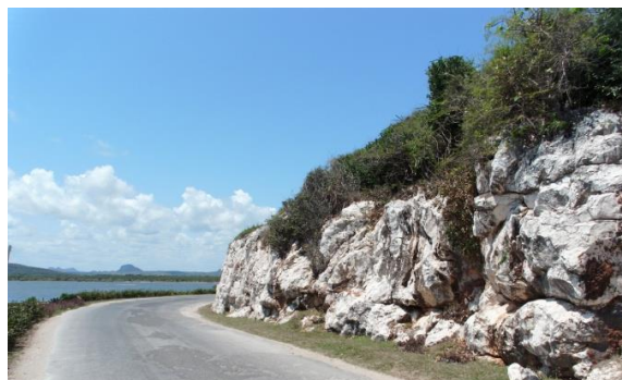
Figura 16. Corte en el lado W de la carretera Holguín-Gibara.
