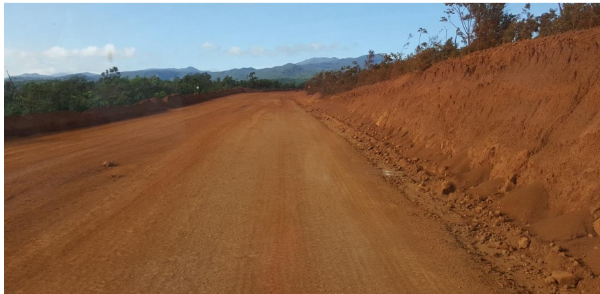
Figura 1. Talud en yacimiento lateríticos de Moa.
