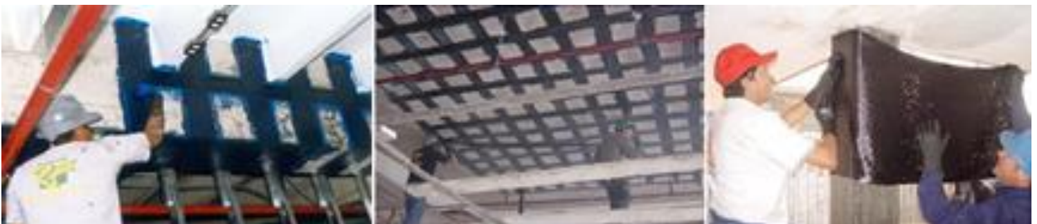
Figura 1. Reforzamientos de elementos de hormigón armado con sistemas de PRF. a) Reforzamiento de viga. b) Reforzamiento de losa. c) Reforzamiento de columna (Rosero, 2013).
