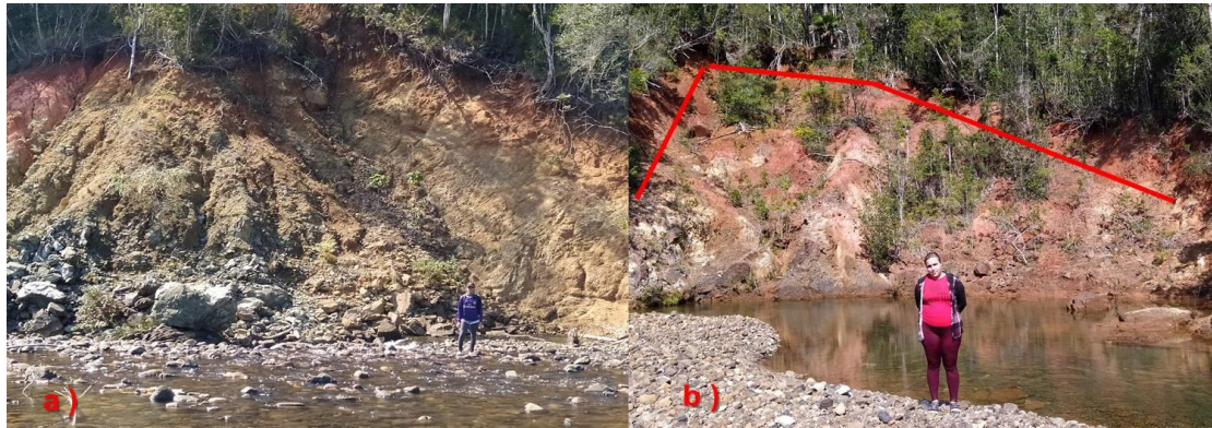
Figura 6. a) Deslizamiento ocurrido a 10 m hacia el sur del punto de muestreo 5, b) deslizamiento ocurrido en el punto de muestreo 5.
