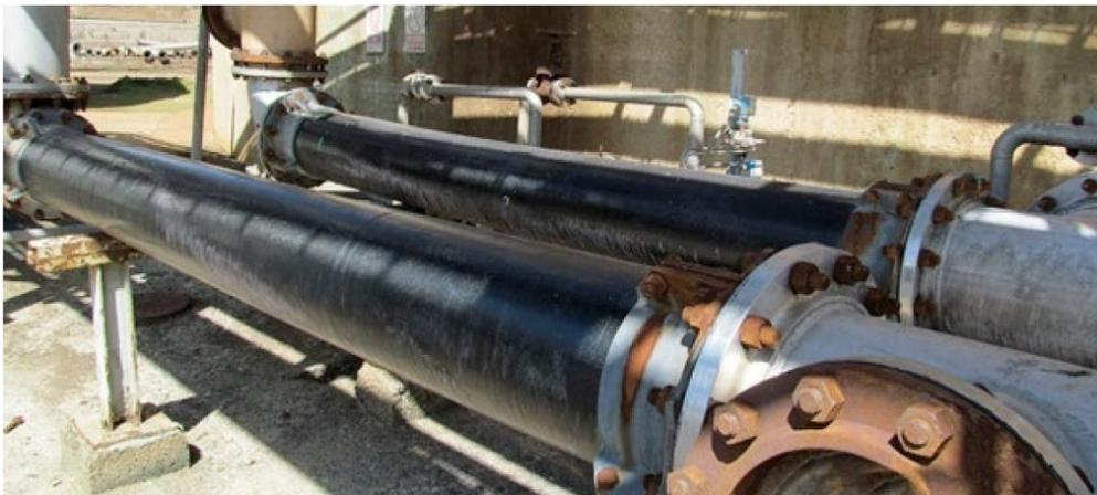
Figura 4. Sustitución de tubería de titanio por tubería PEXGOL.
