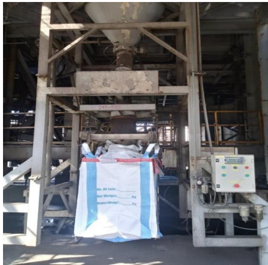
Figura 8. Unidad ensacadora totalmente restaurada en prueba de funcionamiento: Fuente: foto del archivo ECG.
