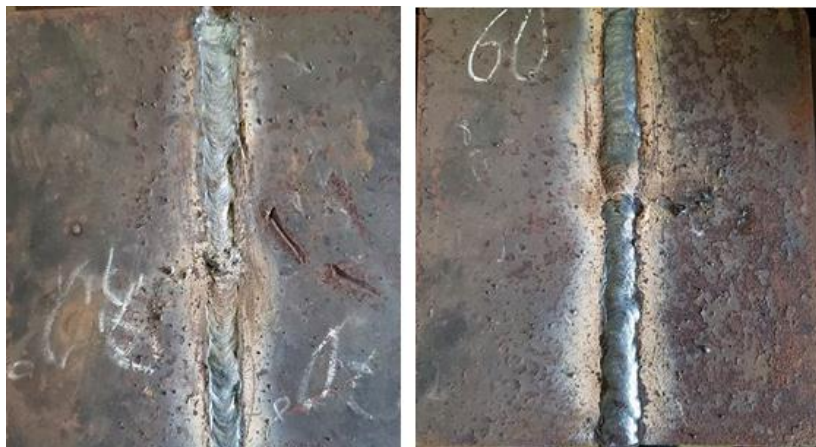
Figura 2. a) Soldadura con bisel a 30°. b) Soldadura con bisel a 35°.
