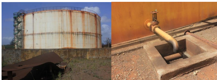
Figura 1. a) Vista del tanque 7. b) Sistema de drenaje.
