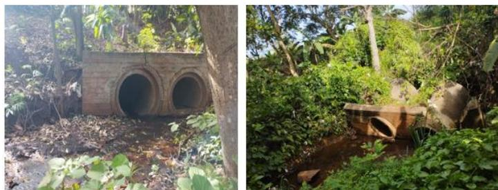
Figura 4. Alcantarillado en mal estado. Puntos 5 y 6.
