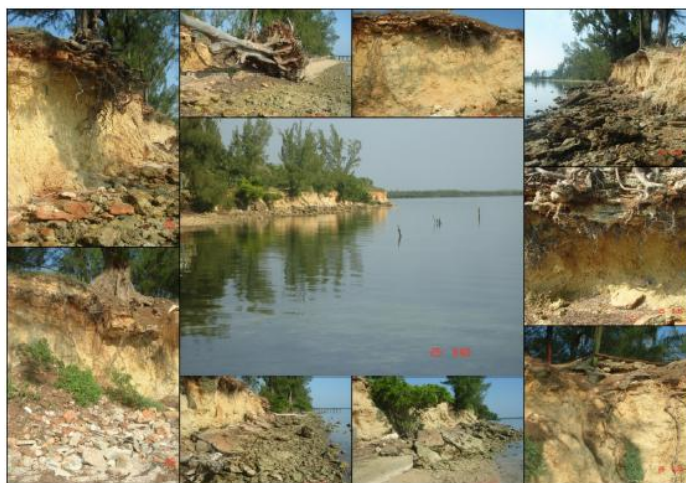
Figura 2. Erosión de los suelos.
