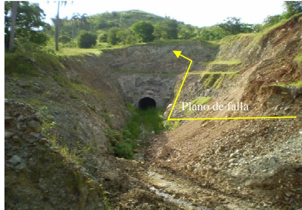
Figura 9. Influencia de las estructura geológica en la estabilidad del emboquille, la flecha señala el plano de falla.
