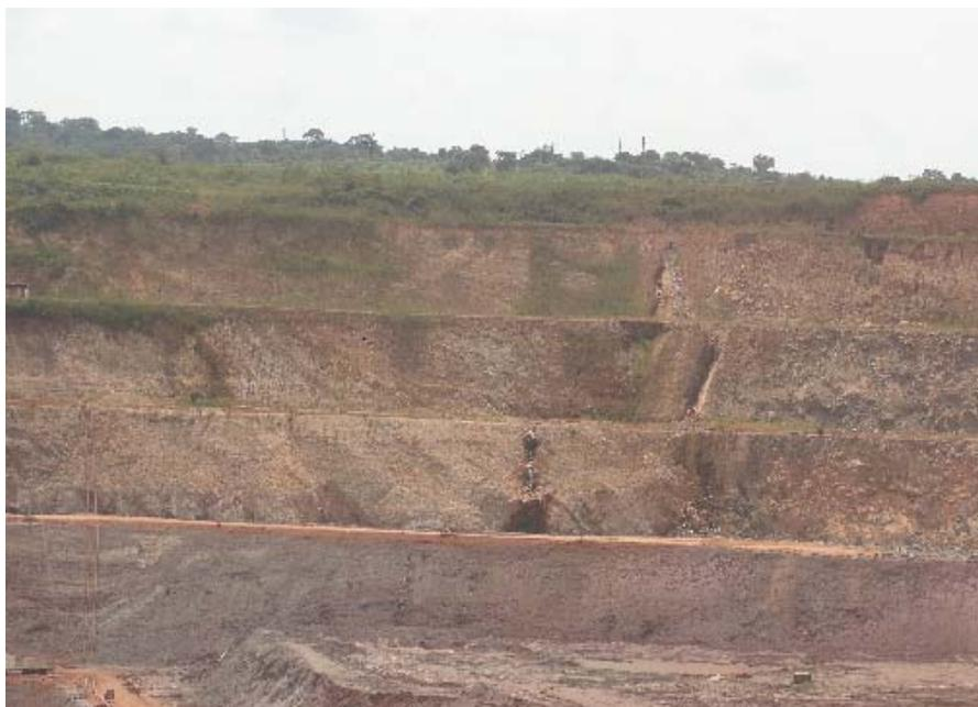
Figura 6. Foto que muestra los deslizamientos estructurales con superficies en cuña en la mina de Catoca.
