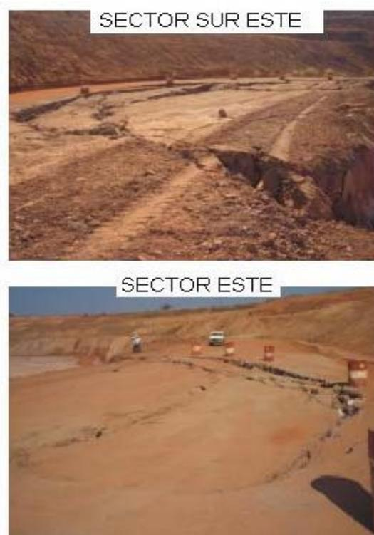
Figura 9. Deslizamiento de tipo circular en la mina de Catoca.
