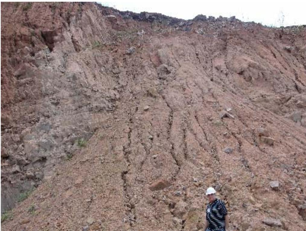
Figura 8. Deslizamiento por una superficie plana en los cortes de la mina de Catoca.
