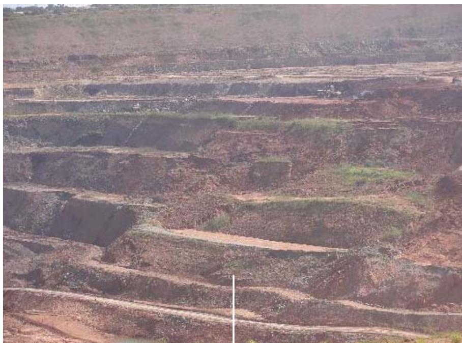
Figura 7. Foto que muestra los deslizamientos plásticos con superficie circular.
