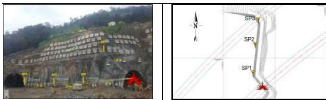
Figura 13. Localización de sismógrafos (izq) y ubicación de estos en los portales de entrada (der).
