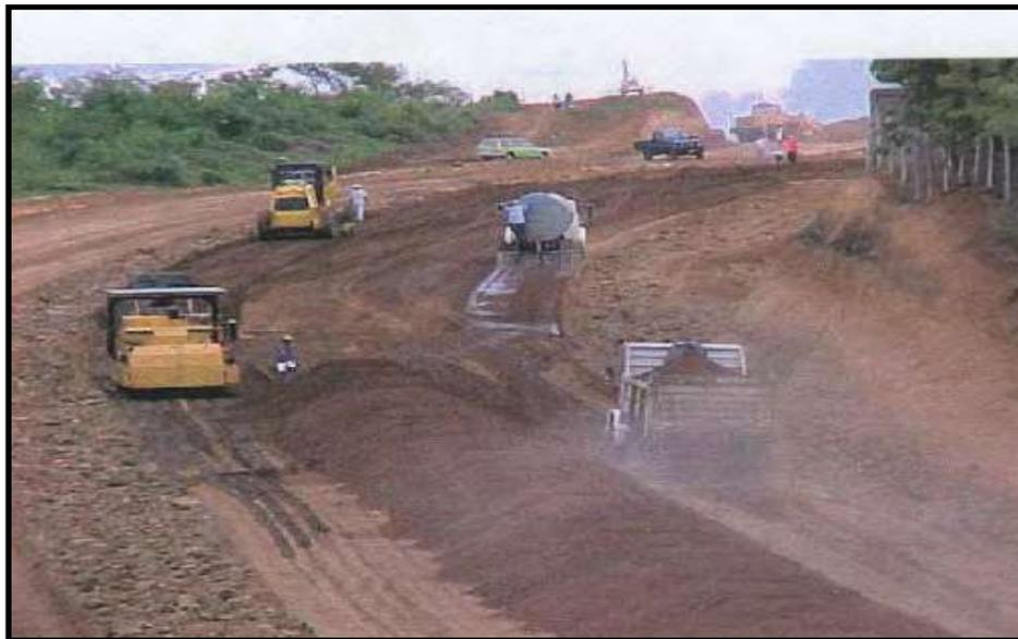
Figura 5. Construcción de los terrenos base. Fuente: Fonseca-Aguilar (2024).
