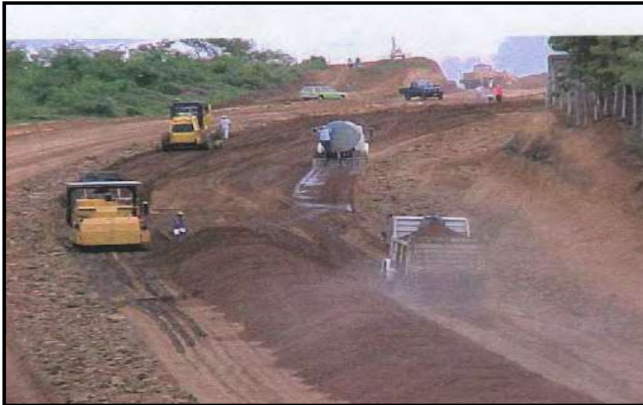
Figura 5. Construcción de los terrenos base. Fuente: Fonseca-Aguilar (2024).
