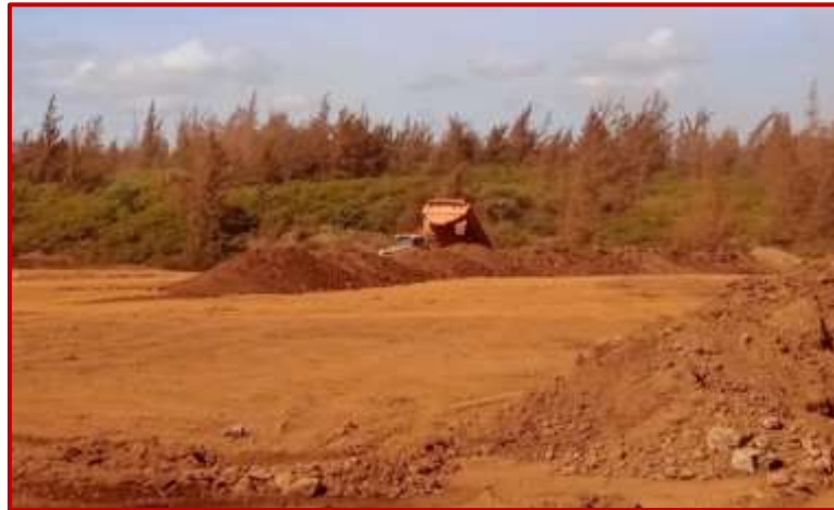
Figura 7. Operaciones en las plazoletas de secado solar. Fuente: Fonseca-Aguilar (2024).
