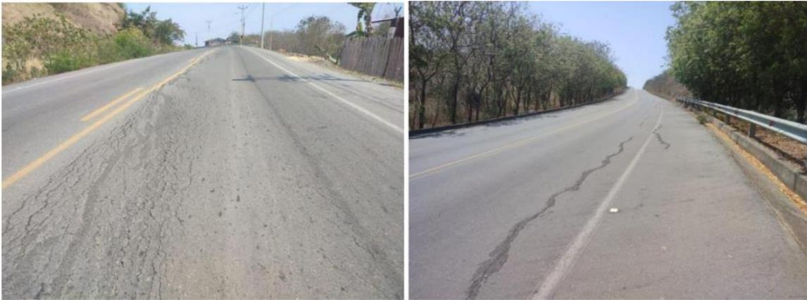
Figura 2. Grietas detectadas en la carretera a partir de la inspección visual (Fuente: elaboración propia).
