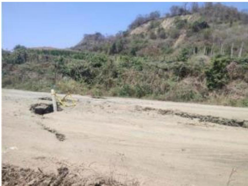
Figura 16. Correlación de los desplazamientos con los daños en la vía. (Fuente: elaboración propia).
