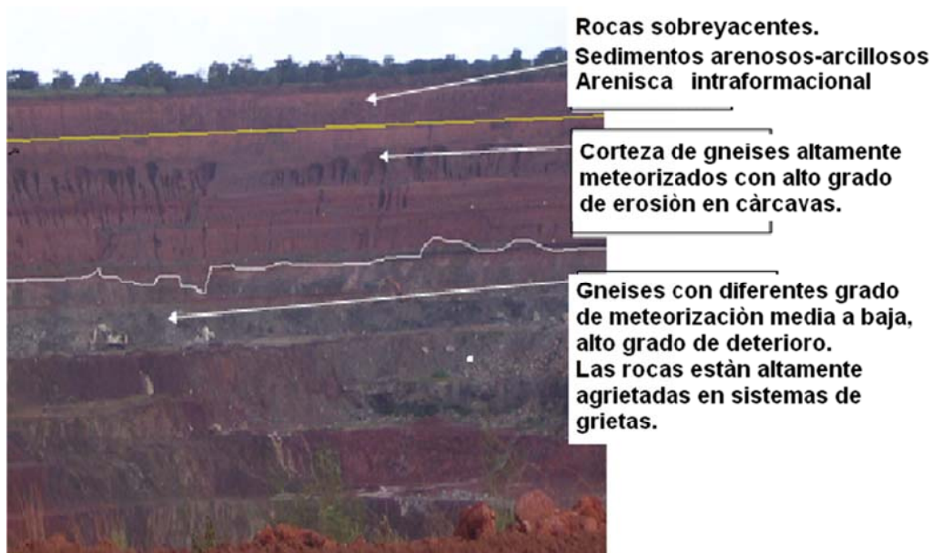
Figura 2. Distribución de los sedimentos sobreyacentes, los gneis según su meteorización y agrietamiento. Obsérvese el alto grado de erosión en cárcavas en estos sedimentos.
