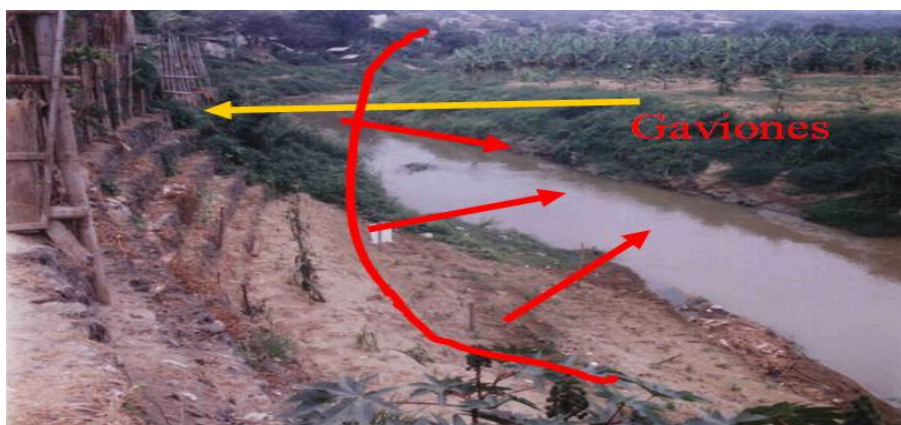
Figura 2. Colocación de gaviones para estabilizar el talud.
