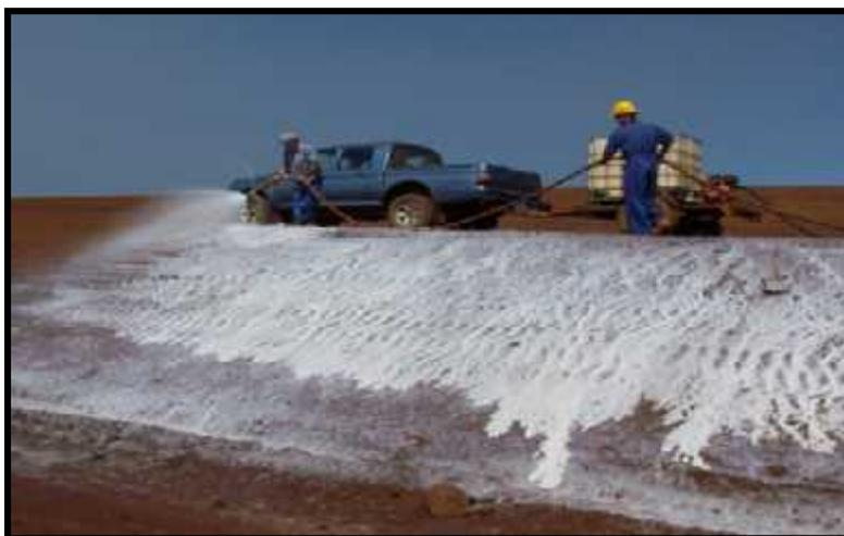
Figura 2. Aplicación de polímero sellante para el control de la erosión.
