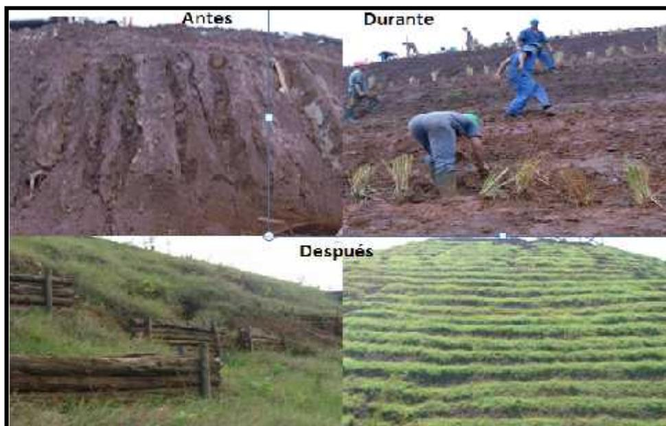
Figura 4. Proceso de estabilización de talud aplicando la bioingeniería.
