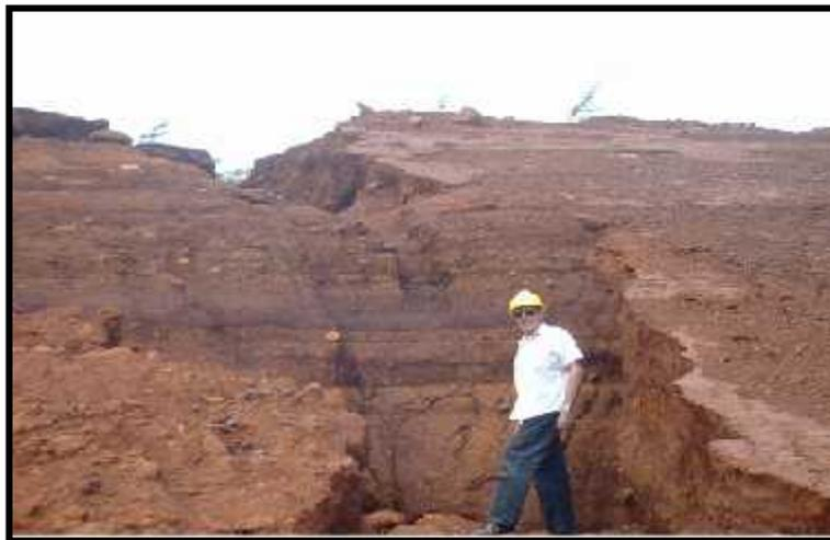
Figura 1. Cárcava en dique de la presa provocada por la erosión hídrica.
