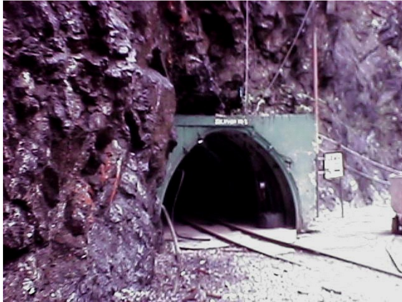
Figura 11. Socavón principal de la mina Merceditas.
