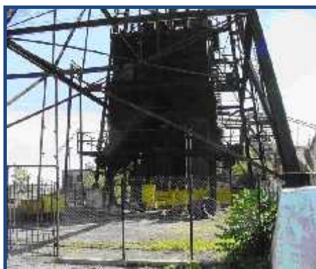
Figura 2. Vista del pozo principal de la mina Matahambre (Fonseca 2012).
