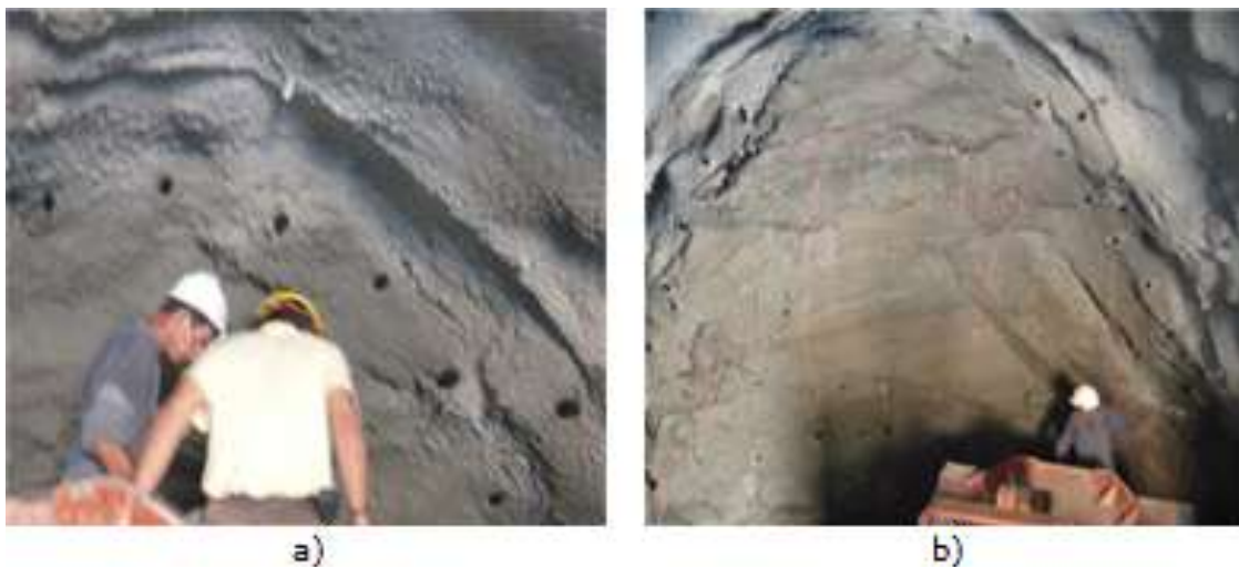
Figura 8. Registro fotográfico del contorneado obtenido con la voladura de los barrenos de contorno con cordón detonante de alto gramaje de 40 g/m y 8,1 mm de diámetro (a), proceso de carga de los barrenos de contorno cargados con cordón detonante. Los registros fotográficos a) y b) corresponden a las argilitas en el frente de excavación del túnel de Buenaventura.
