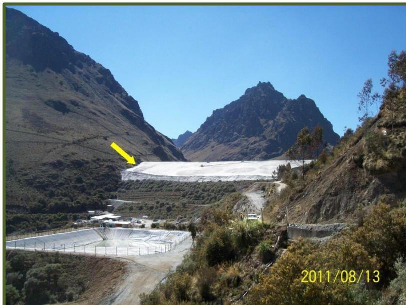
Figura 3. Dique principal del depósito de relaves de flotación, al pie de este talud se ha construido el contrafuerte para contribuir a la estabilidad del depósito (Foto del autor 2011).
