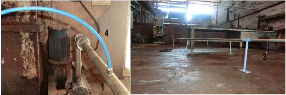
Figura 1. Instalación experimental. 1: reactor tubular flujo pistón a escala de banco, 2: bomba de diafragma, 3: toma muestras, 4: sistema de inyección de reactivo.
