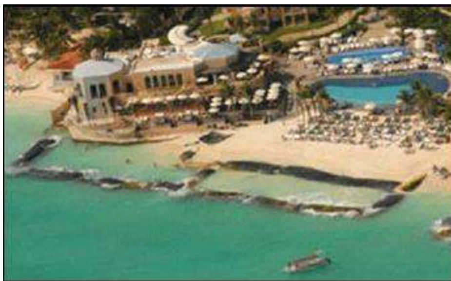
Figura 9. Geotubos en playa del Carmen. Figura tomada de Guido-Aldana et al. (2009).
