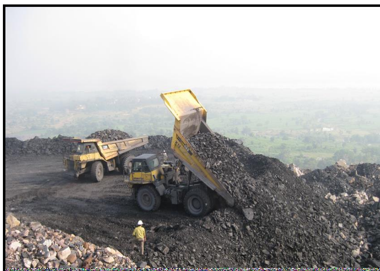
Figura 7. Labores de construcción de la escombrera (Fernández 2017).
