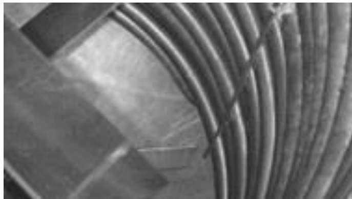
Figura 2. Zona cercana a la falla sin soportes.
