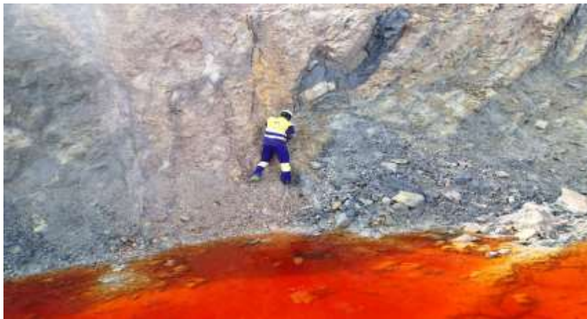
Figura 5. Percolación de agua en la base del talud III.
