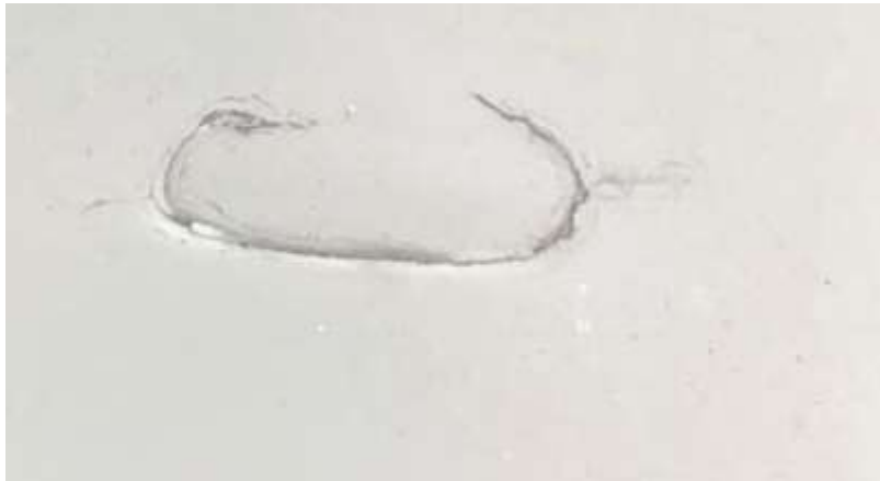
Figura 4. Ligera depresión de la unión que falló.
