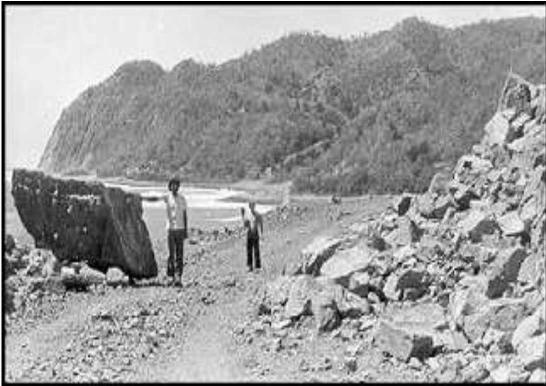
Figura 8. Foto del deslizamiento de roca asociado al terremoto de Pílon de 1976, en el tramo de la carretera comprendido entre la localidad La Bruja y Palma Mocha.
